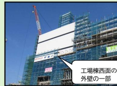
令和3年3月現在、工場棟各階においては部屋ごとの仕切り壁や電気設備関係の配管工事が進められています。外観は一部の外壁塗装が終了し、足場が撤去されて完成形を少しだけ見ることができます。さらに現場では、西面（正面）から向かって右手の飾り壁も施工済みのため、足場の向こうに出来上がりのひし形模様の外壁をうっすらと見ることができるようになりました。
