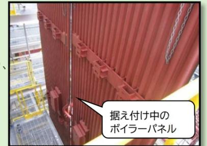
令和3年4月～6月においては、3F可燃ごみプラットホームへ上るランプウェイ（東側）や、管理棟及び付属棟の建設工事、ボイラーパーツの据え付け・溶接工事、蒸気タービン発電機及び周辺機械の据え付け等が予定されており、今後も施設完成に向けて続々と主要工事を進めていきます。
