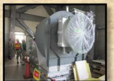
内蔵された誘引ファンにより排ガスを引き込み、煙突へと導く機械。他の送風機と合わせて、空気の流れをコントロールする。
