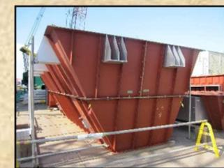
焼却炉・ボイラーからの排ガスに活性炭と消石灰を吹き込み、排ガス中に含まれるダイオキシン類等の有害物質を、ろ布と呼ばれる織布や不織布を用いてばいじんと共にろ過捕集する装置。バグフィルタとも呼ばれる。
