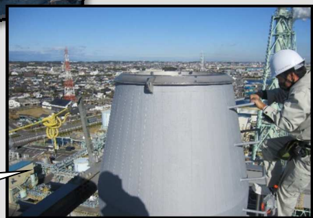
煙突(1号内筒) の先端
